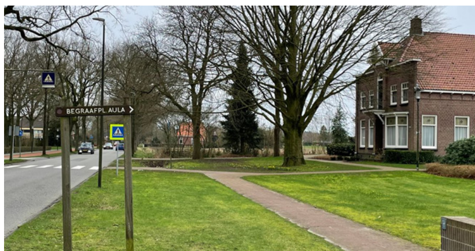
Rechts de voorkant van het pand waar veel aan moet gebeuren, wil voldoen aan de duurzaamheidseisen van de gemeente Tynaarlo© RTV Drenthe / Mathijs Renkema
