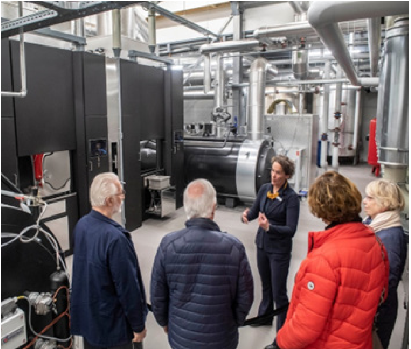
In het Crematorium Tilburg is onder andere de nieuwe elektrische verbrandingsoven te zien.
